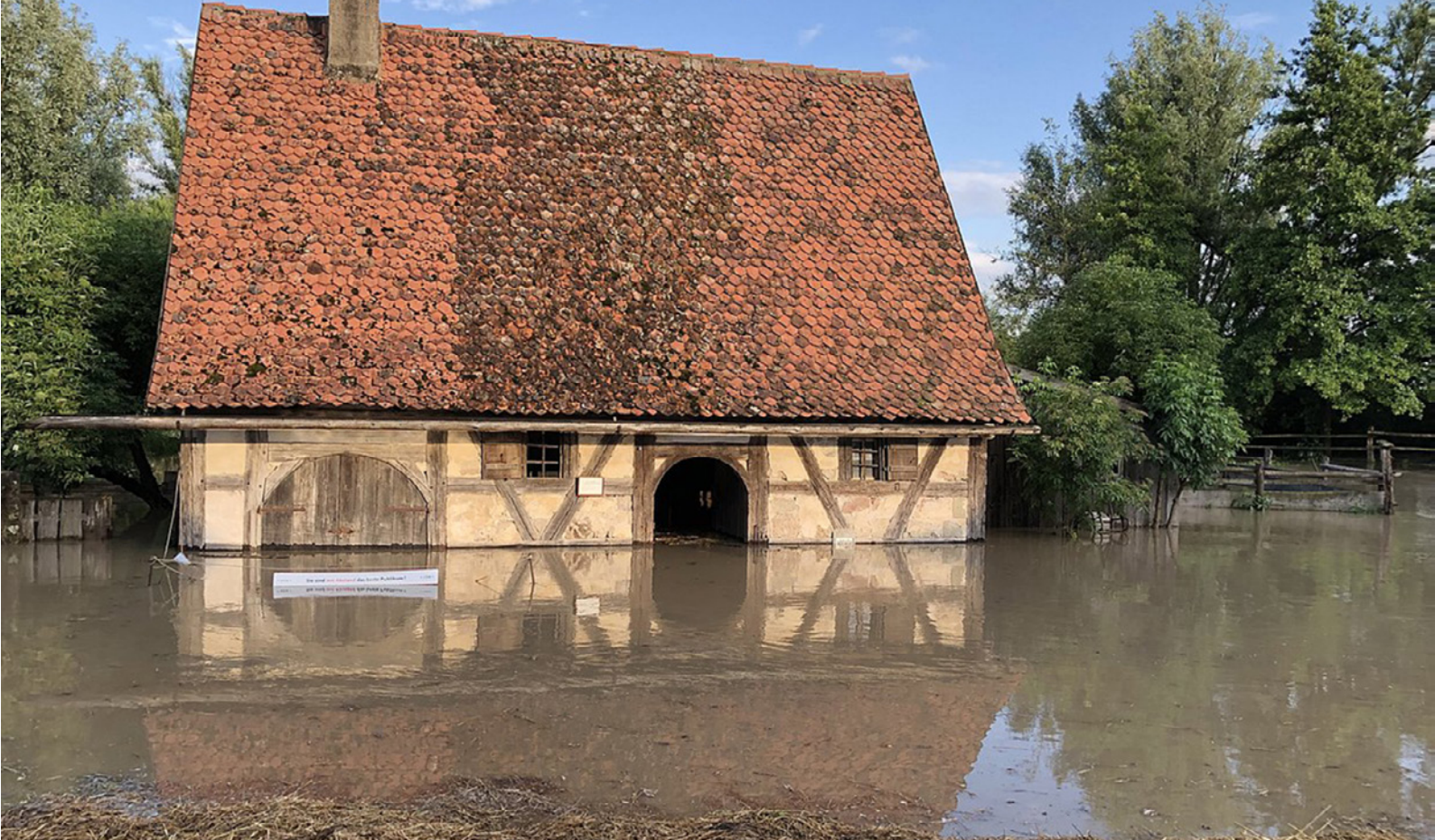
Fachwerkgebäude in Bad Windsheim (Deutschland) nach extremen Niederschlägen am 15. Juli 2021. © Freilandmuseum Bad Windsheim
