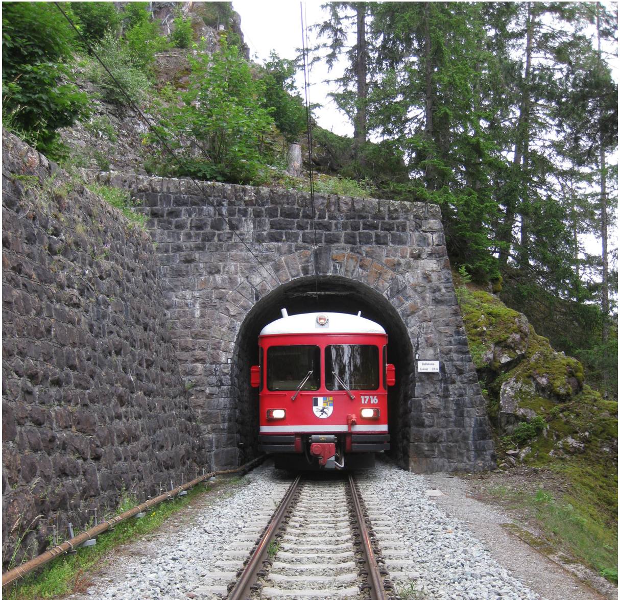
Der Bellaluna-Tunnel der Rhätischen Bahn an der Albulalinie (Foto: EKD)
