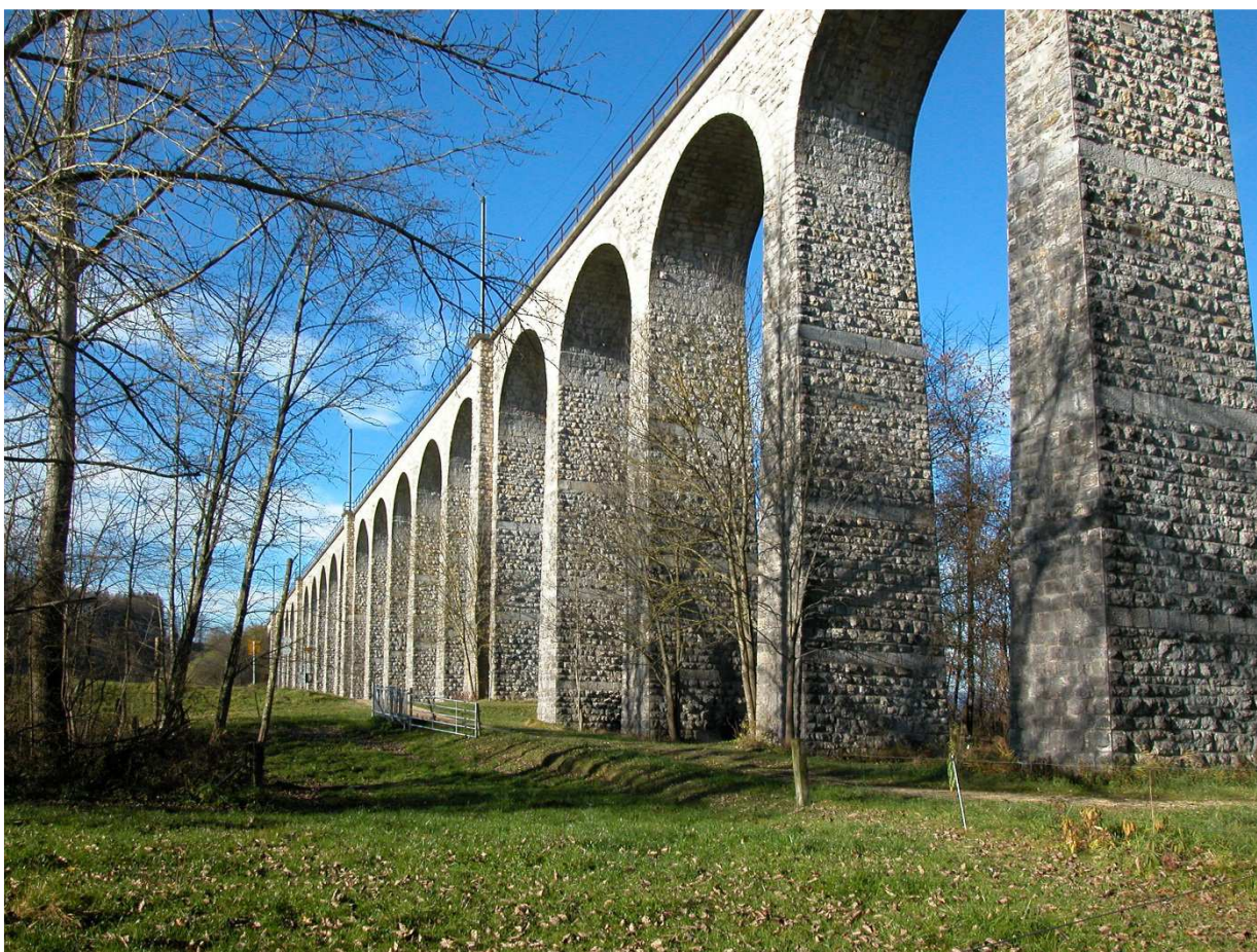
Saane-Viadukt der BLS bei Mauss-Gümmenen, erbaut 1900-1901. Bild: N. Caviezel
