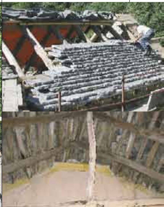
5–6 Travaux sur le toit de pierres plates 7 La charpente en bois de chataigner
