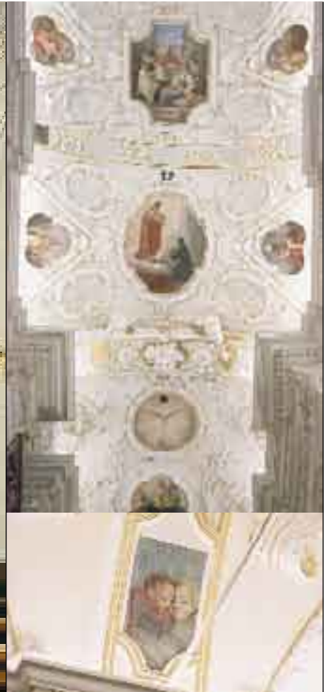
5 La voûte de la chapelle 6 La fresque baroque de la voûte ravivée
