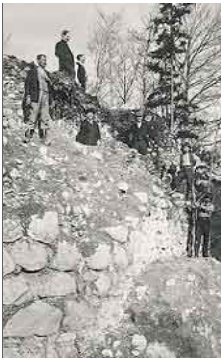
2 Travaux de fouilles en
