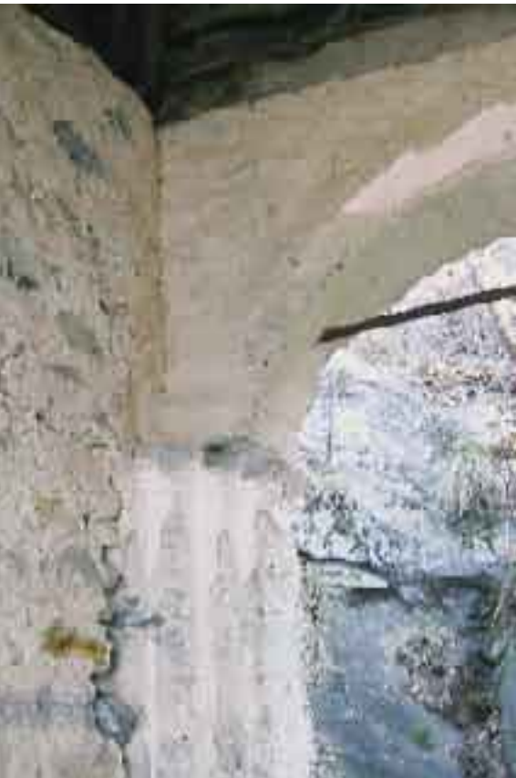
2 Arcs dans le portique extérieur
