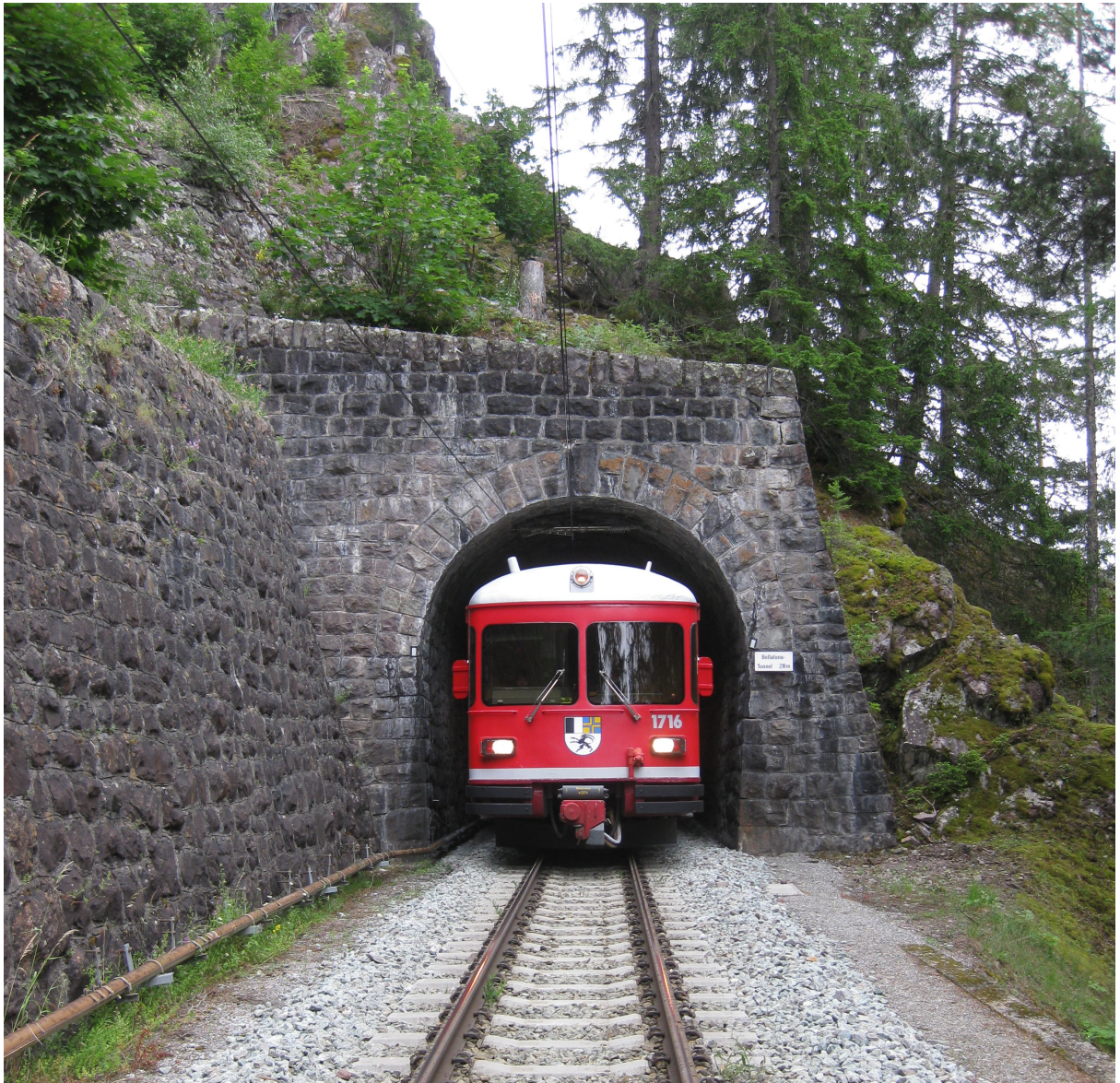
Le tunnel Bellaluna des Chemins de fer rhétiques sur la ligne de l'Albula (Foto: CFMH)
