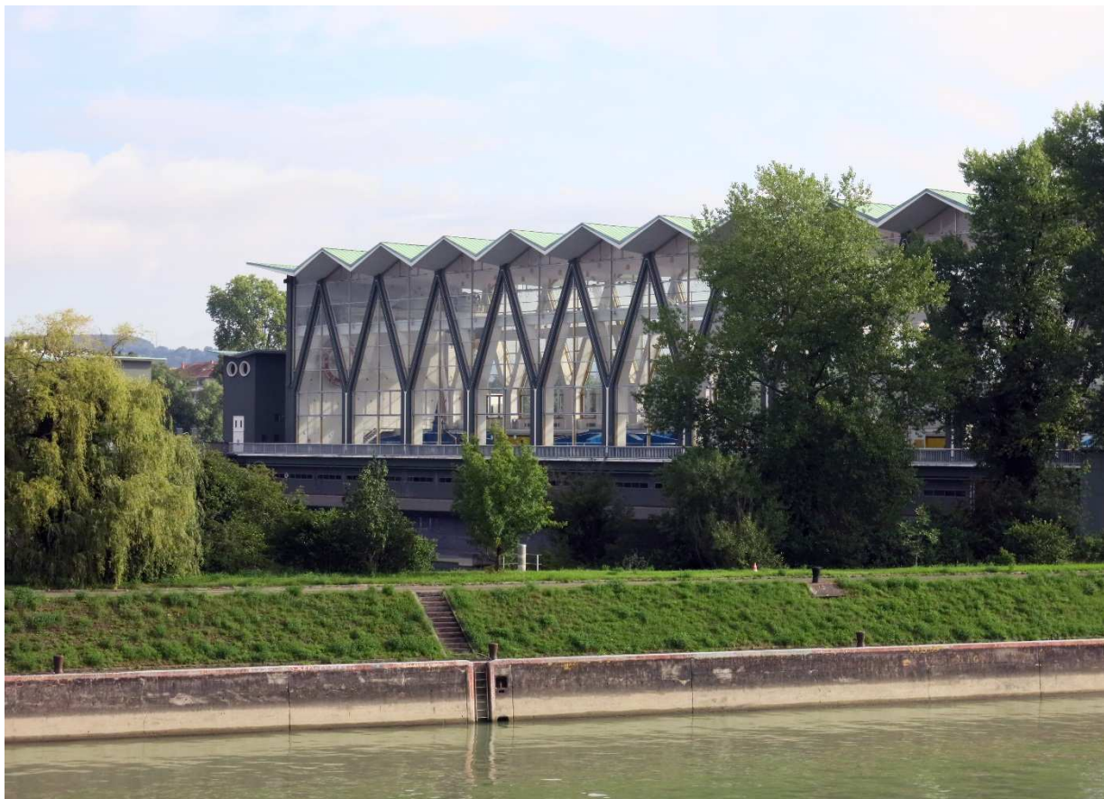
Centrale électrique de Birsfelden, construite entre 1951-1954 par Hans Hofmann. Photo : N. Caviezel
