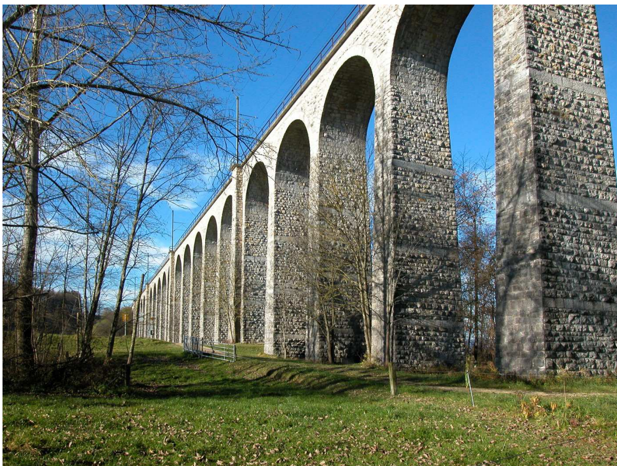
Viaduc BLS sur la Sarine près de Mauss-Gümnenen, construit 1900-1901. Photo : N. Caviezel
