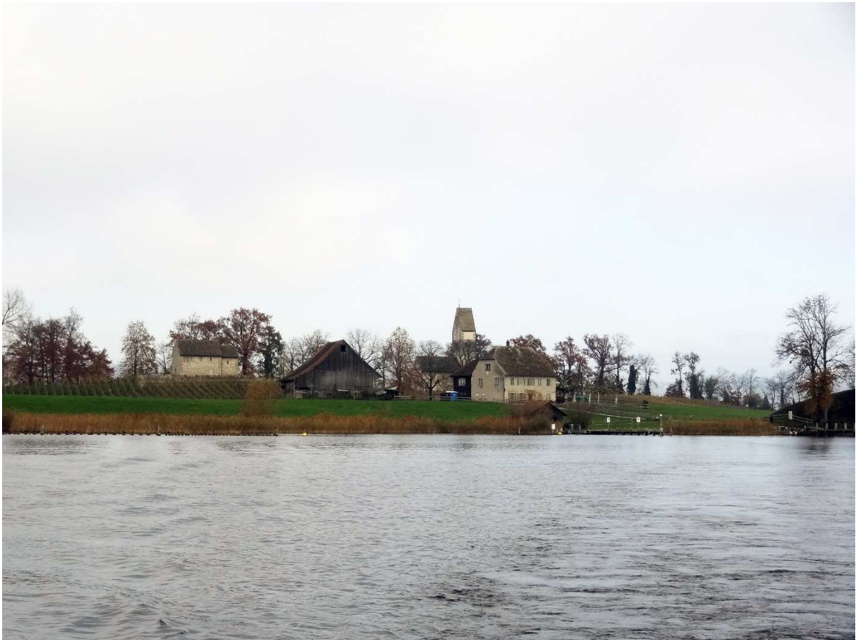
Freienbach, île d'Ufenau, vue du sud. Photo : V. Bösch
