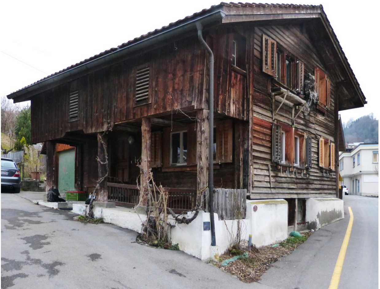
Maison en madriers de 1292-1293 à Steinen. (Photo : Service des monuments historiques du canton de Schwytz).
