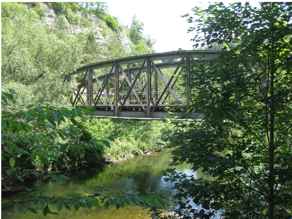
Il ponte ferroviario sulla Birsra presso Liesberg (Foto: CFMS)
