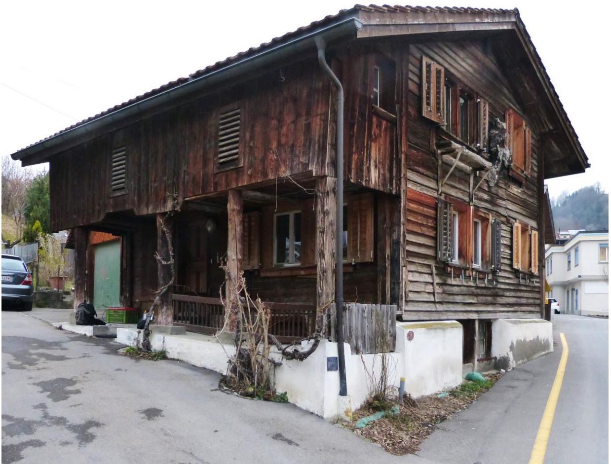
Costruzione in legno del 1292/1293 a Steinen (Foto: Ufficio tutela dei monumenti del Cantone di Svitto).
