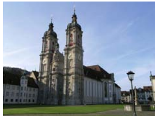
CH-St-Gall-23_La cour de l'abbaye vue de l'est © SG-Bodensee Tourismus
