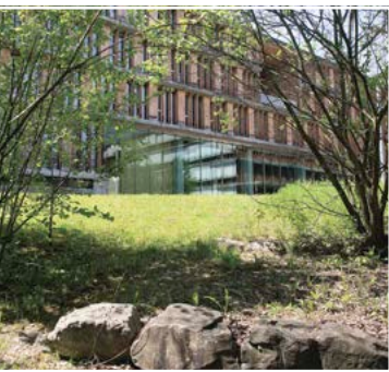
UVEK-Verwaltungsgebäude in Ittigen (BE).
