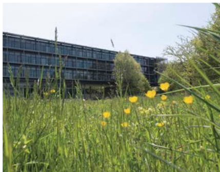
Das BAFU-Gebäude an der Worblentalstrasse.
