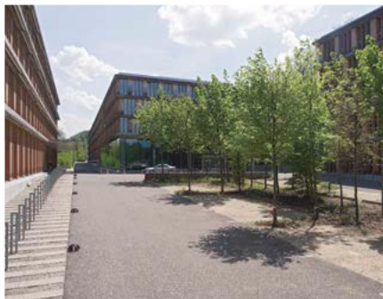
Unversiegelte Parkplätze beim UVEK-Verwaltungszentrum.
